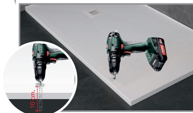
3 • Remplacez la mèche par une mèche adaptée au matériau du sol sur lequel elle a été installée et continuez à percer le sol en dessous jusqu'à une profondeur totale de 10 cm.
